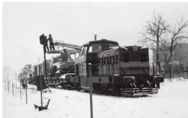
Oprava návěstidla stanice Zárubek za pomoci pracovního vlaku vedeného lokomotivou řady T 444.0
